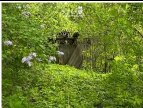
Apbūve ar kadastra apzīmējumu 21000010607002, 21000010607003 sliktā tehniskā stāvoklī
